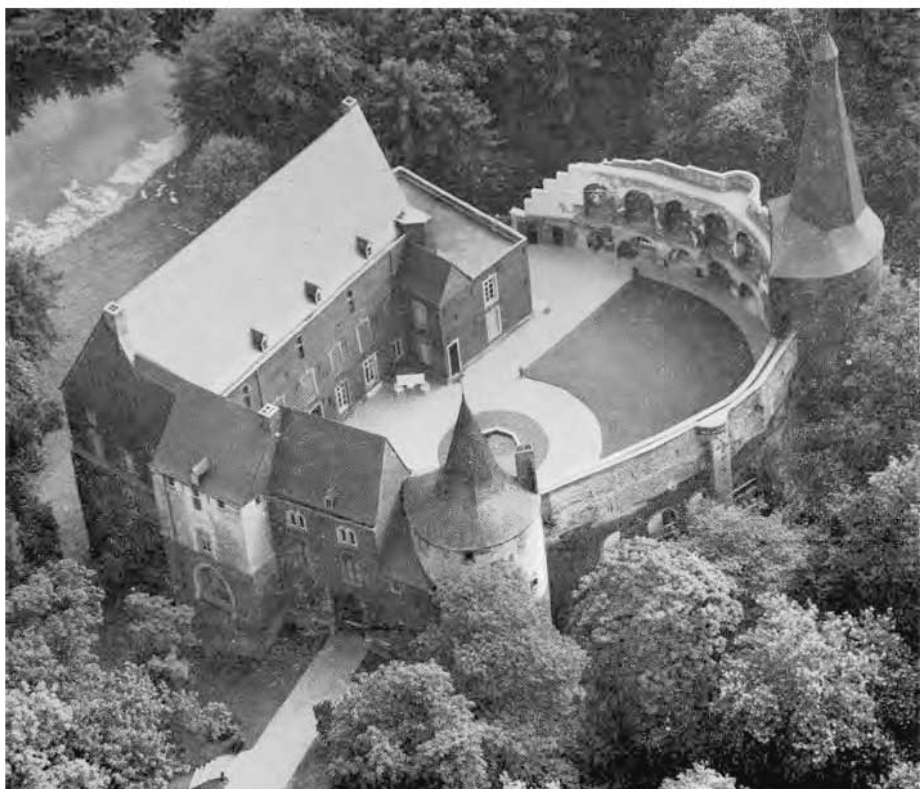
Luchtfoto van het kasteel Horn (Nederlands Limburg) vanuit het noord-oosten na de restauratie. De oudste delen dagtekenen uit het 2e kwart van de XIIIe eeuw. De huidige poort is XVe-eeuws; links ervan bemerkt men de poorttoren van de XIIIe-eeuwse burcht. Het hoofdgebouw is in oorsprong XIIIe-eeuws en werd in de XVe eeuw vergroot (Foto K.L.M.-Aerocarto. In Dr. P.A.M. GEURTS, De graaf van Horne, Filips van Montmorency (1524-1568) , p. 4).
