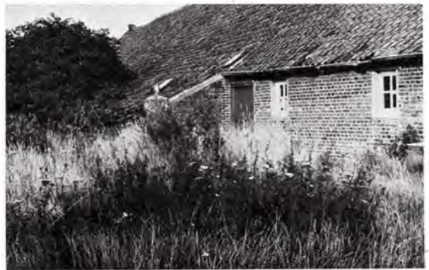
Oudste thans nog bestaande, boerderij nabij de Kootspeel. Vermoedelijk ong. 1750. Dak later gerestaureerd. Rietbedekking is verwijderd, en dak van waterafvoer voorzien. Het dak loopt schuin af tot bijna aan de grond. Links de onafscheidelijke vlier.
