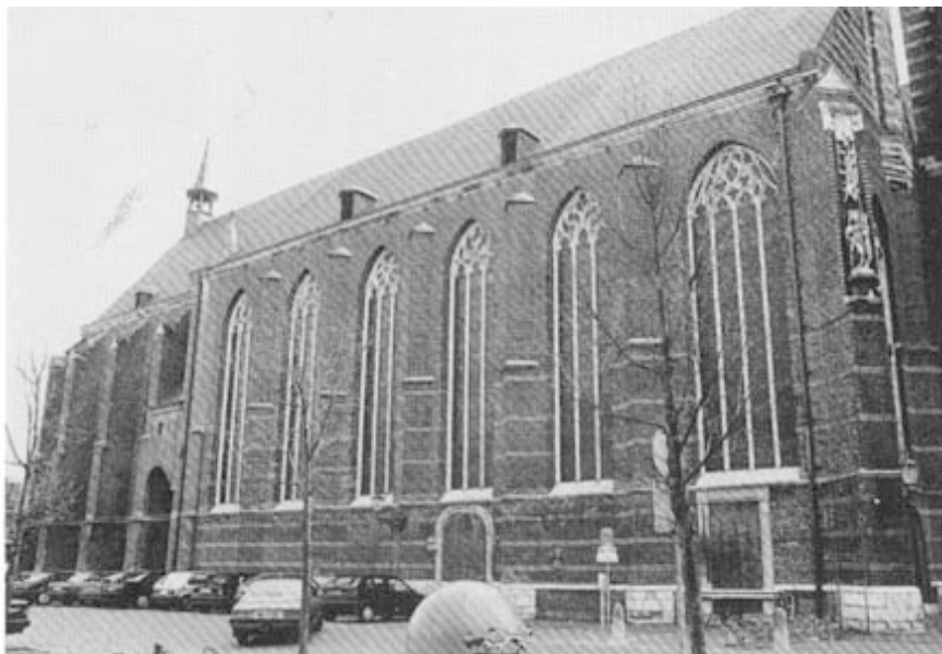
Afb. 3: de noordelijke zijgevel.
