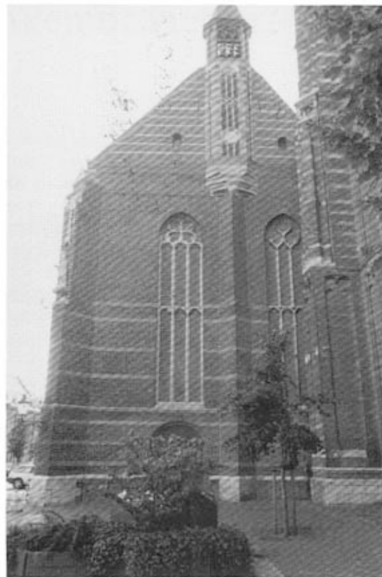
Afb. 10 links: de westelijke gevel van het noordelijke zijschip.
