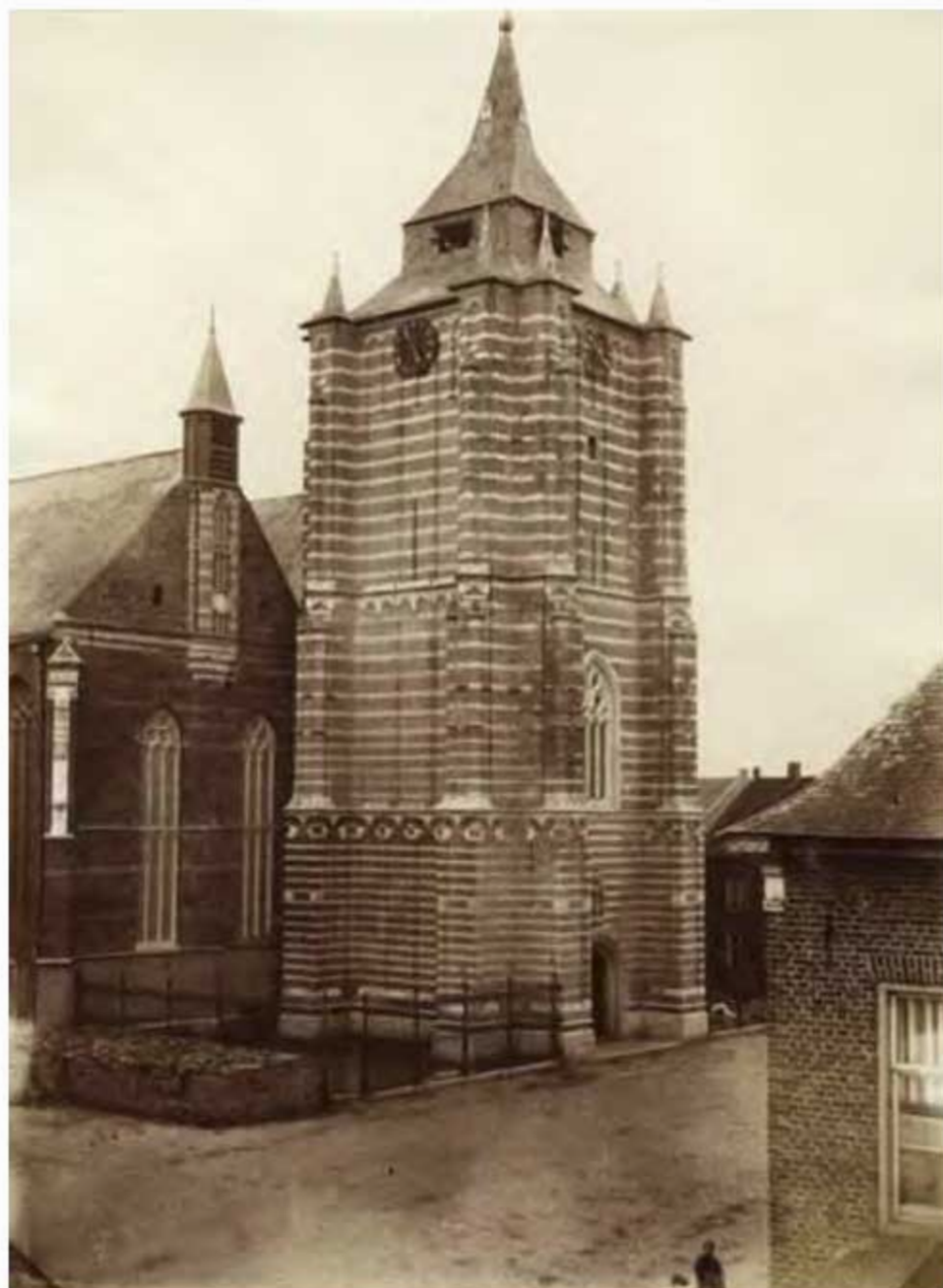
Afb. 1 De St. Martinustoren vlak vòòr de aanvang der werkzaamheden in 1887.
