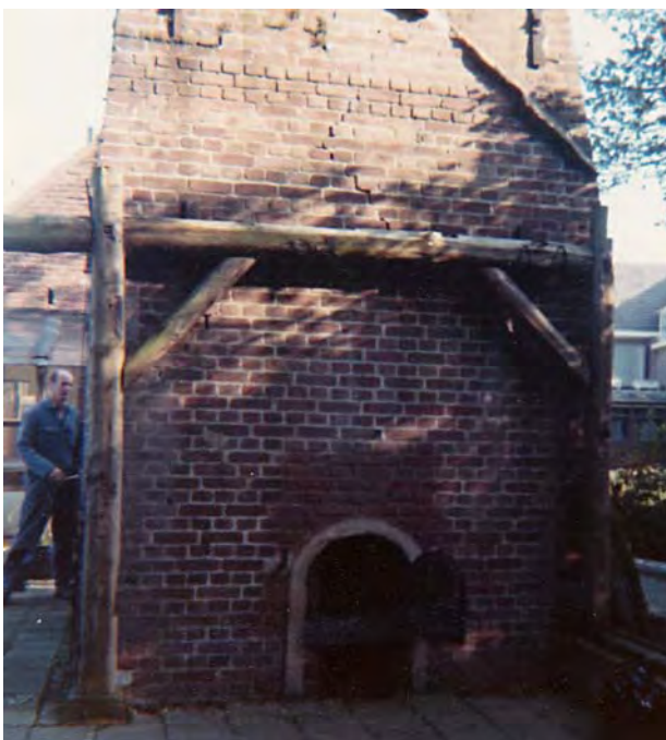
Pijpenoven te Weert. Zuidzijde. Stookgat en restanten van de ondersteuning van het afdak.
