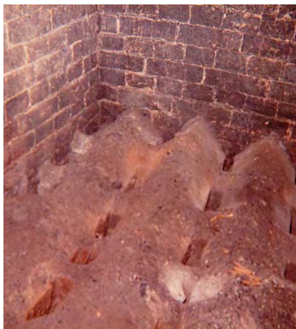
Foto van de ovenvloer met sleuven.
