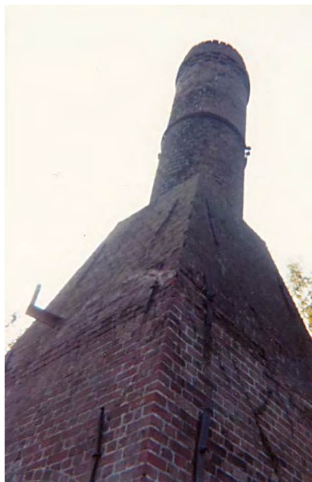
Schoorsteen, met noord- en westzijde.
