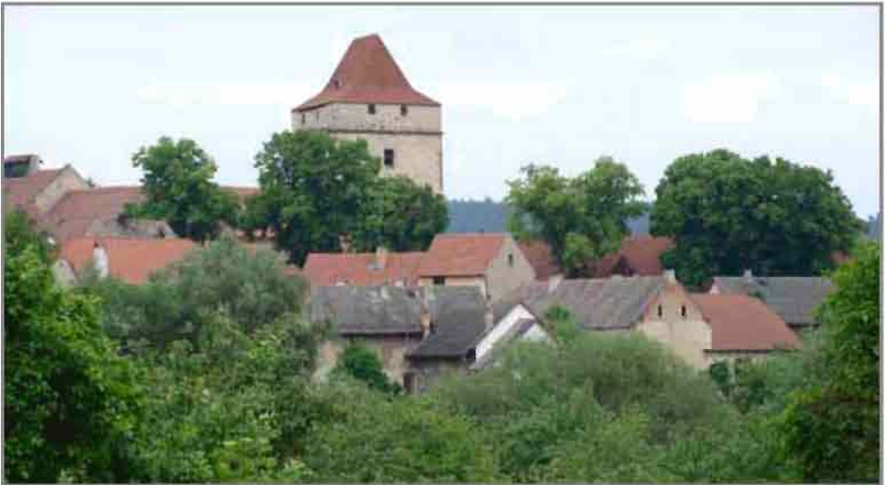
Toren van het kasteel te Dívce.
