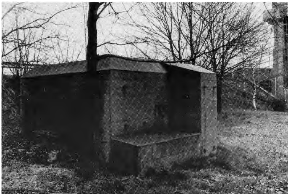
Kazemat bij Sluis 16.
