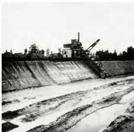
Uitgraven van de IJzeren Man door de graafmachine "de IJzeren Man" genaamd.
